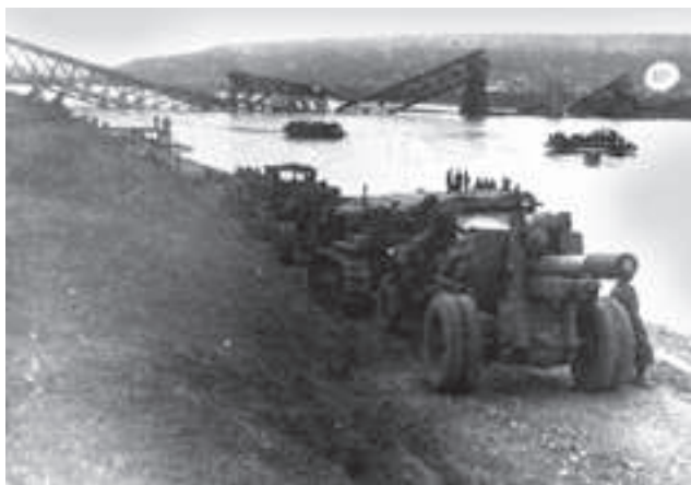
Рис. 1. Разрушенный железнодорожный мост через р. Днестр. Рыбница, март 1944 г.
