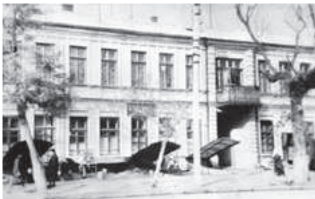
Рис. 2. Первое учебное здание института – г. Тирасполь, ул. Свердлова, д. 15
